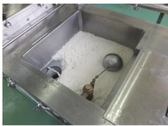
米糠を取除く設備
